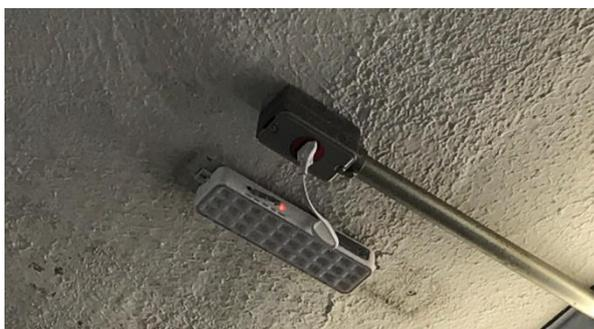
6. **LUZ DE EMERGENCIA:** Atualizamos toda a iluminação de emergência na sala de motores dos elevadores, tendo agora um sistema mais seguro e funcional.
